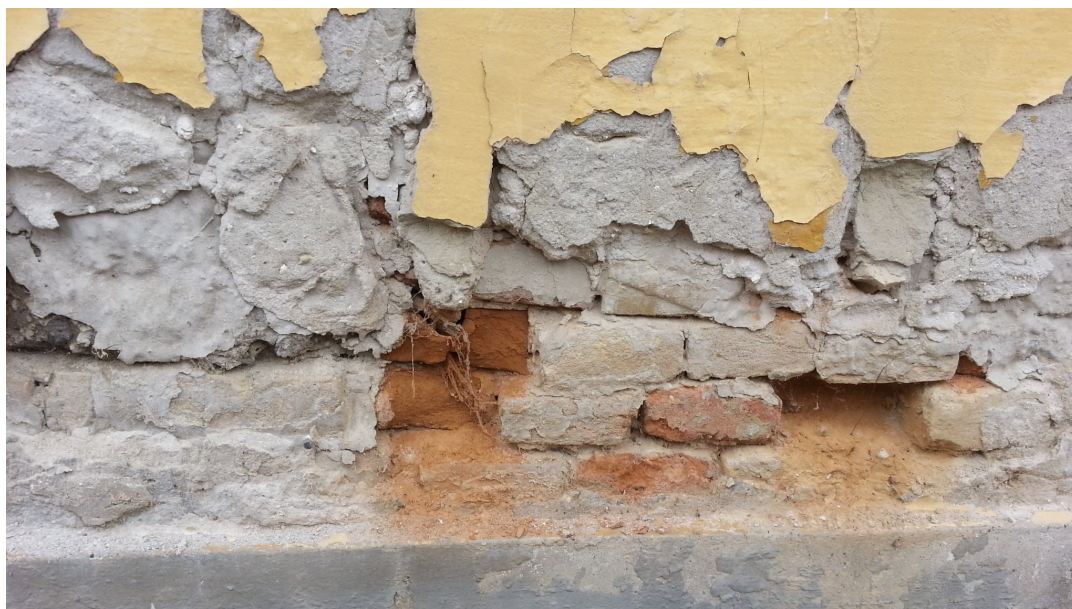
Az épület végénél a beton lábazat is hiányos.
