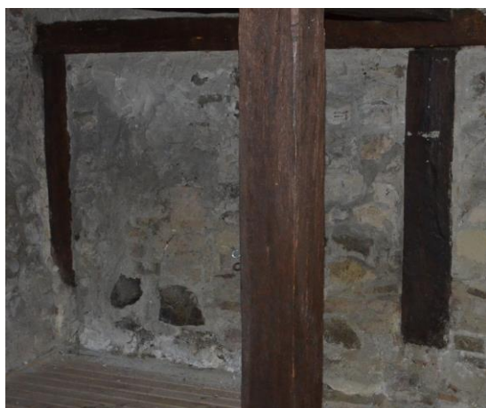
16. kép falban lévő károsodott gerendák
