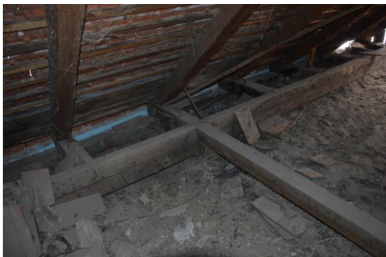
3. kép kötőgerendák és csavarodott fiókváltók
