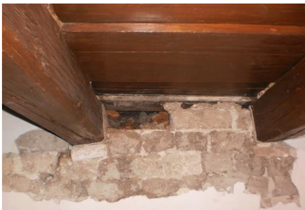
14. kép károsodott gerendavég
