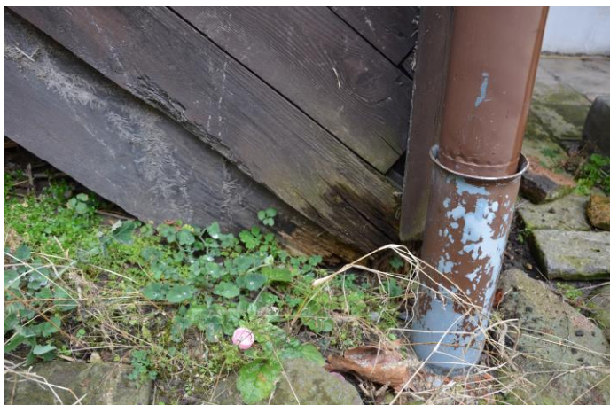
18. kép Gombák által korhasztott, ragasztott fa tartó talajjal érintkező része
