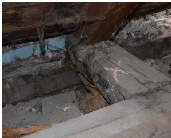
8. kép biológiai károsodott sár-és fiókgerenda
