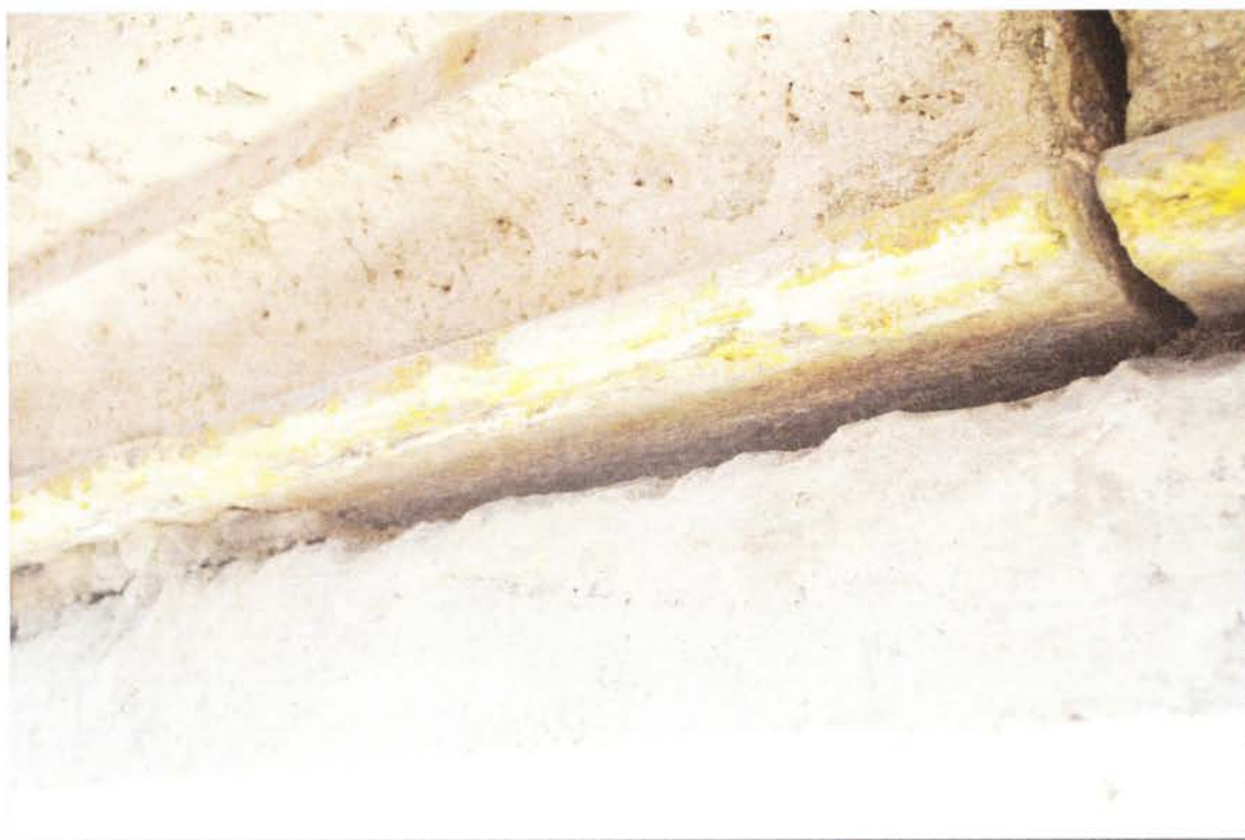
Kő elemek felfekvése a beton lemezre.
