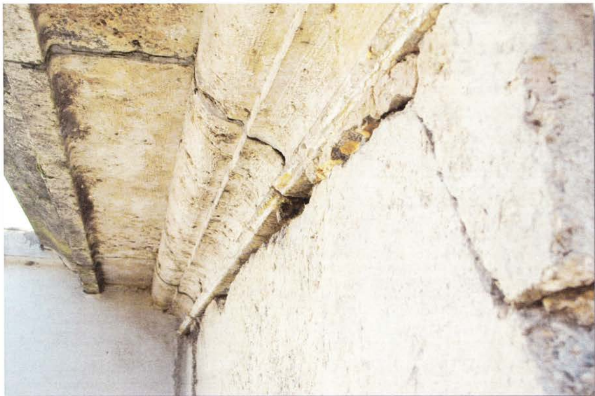
Vakolatcsere alkalmával feltárt felület, a kőpárkány alatt.
