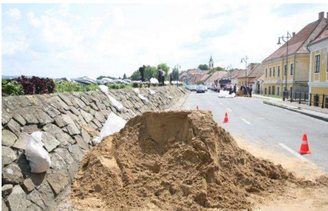
4./13. ábra A révkikötő alatt leggyengébbnek ítélt szakaszon a leborított homok a vízdali fólia terítés leterhelő homokzsákokhoz
