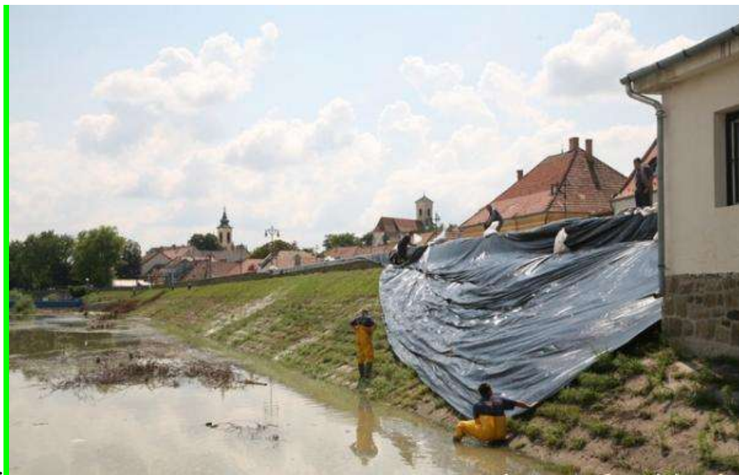
4./13. ábra A révkikötő alatt leggyengébbnek ítélt szakaszon a leborított homok a vízdali fólia terítés leterhelő homokzsákokhoz
