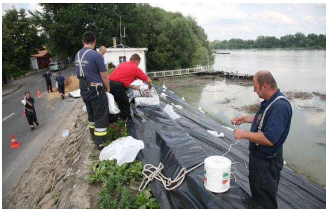
4./15. ábra - A révkikötő felé keskenyedő védmű az elkészült, de még le nem terhelt fóliavédelemmel
